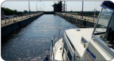
Einfahrt in die Schleuse Rothensee
